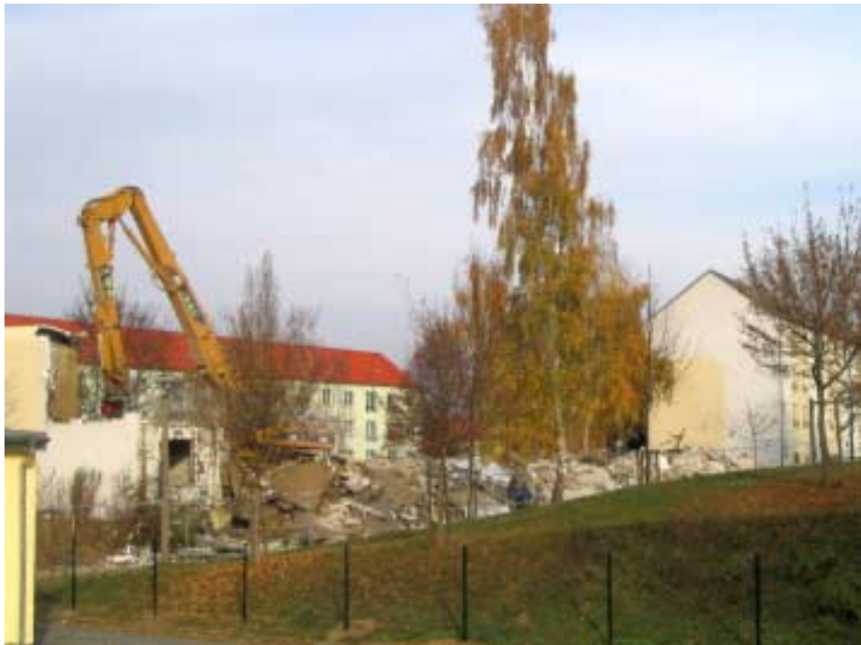
während des Abrisses
