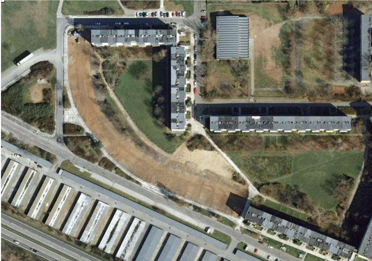
Fläche für die Kurzumtriebsanlage nach Gebäudeabriss
